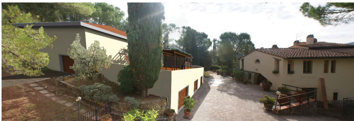
Fotoinserimento 3 – Vista della Cantina e del Fabbricato A
