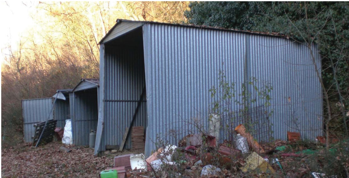
Foto 16 – Vista laterale dei Fabbricati D
