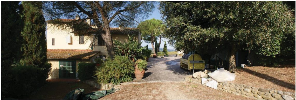
Foto 11 – Vista laterale Fabbricato A
