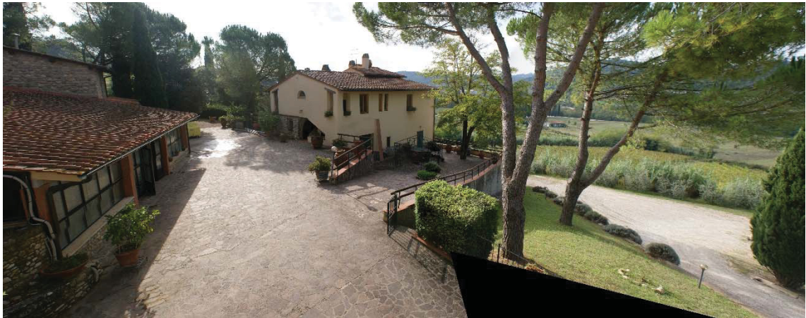
Foto 5 – Piazzale visto dal Fabbricato C
