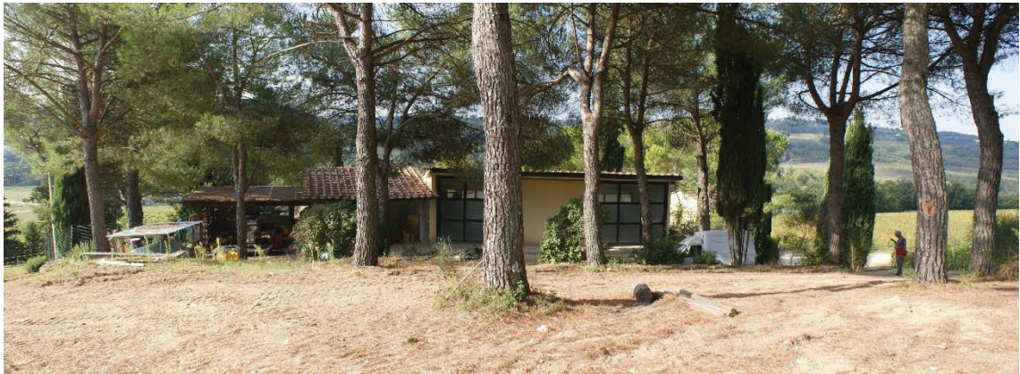
Foto 8 – Vista da monte del Fabbricato B
