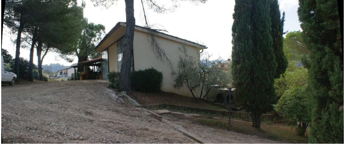
Foto 7 – Vista laterale del Fabbricato B
