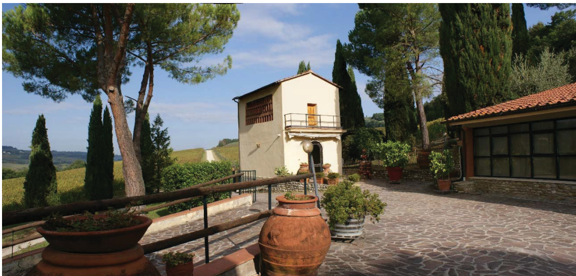
Foto 14 – Vista frontale del Fabbricato C
