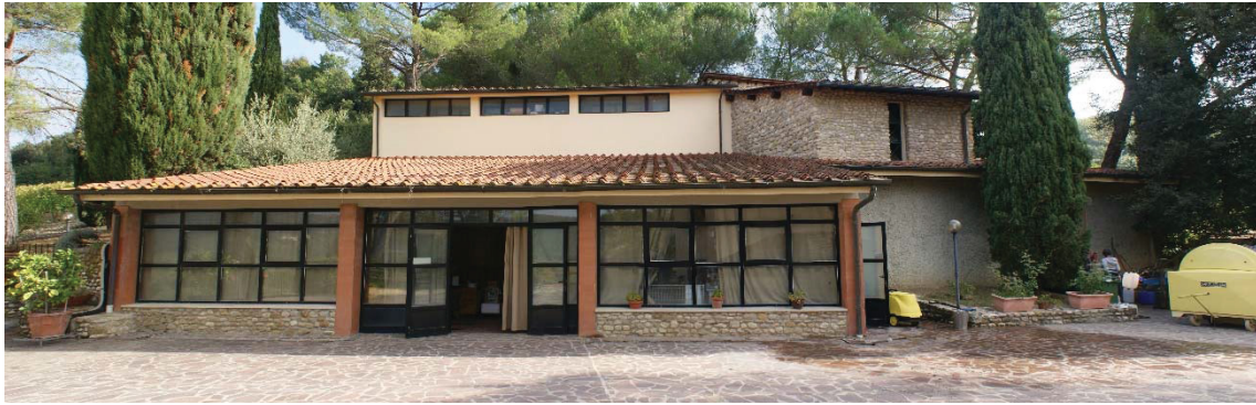
Foto 13 – Vista frontale del Fabbricato B
