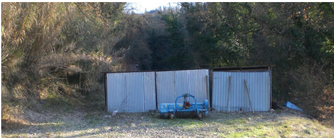
Foto 16 – Vista frontale di uno dei Fabbricati D
